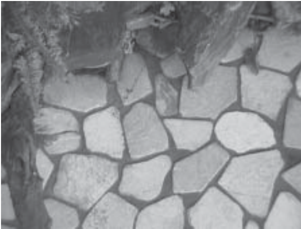
Figura 3 – Demonstração da aplicação do padrão de crazy paving na construção civil.
